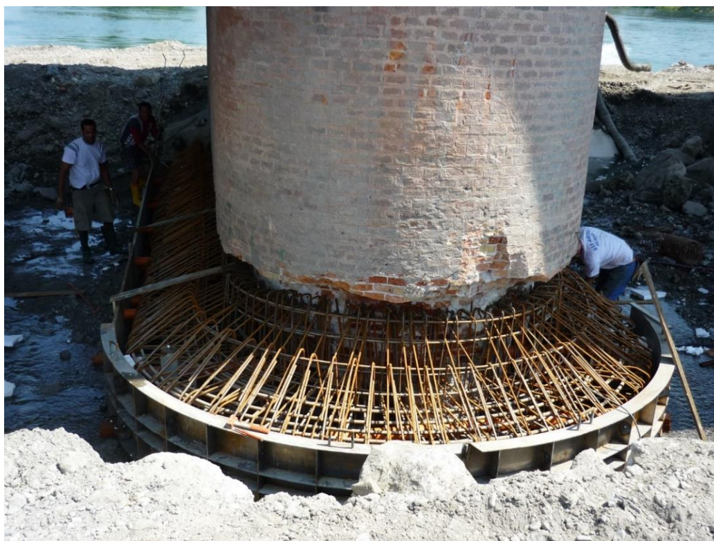
Fig.8 Intervento per l'aumento della capacità portante delle pile (2007) – rifacimento colpetto
