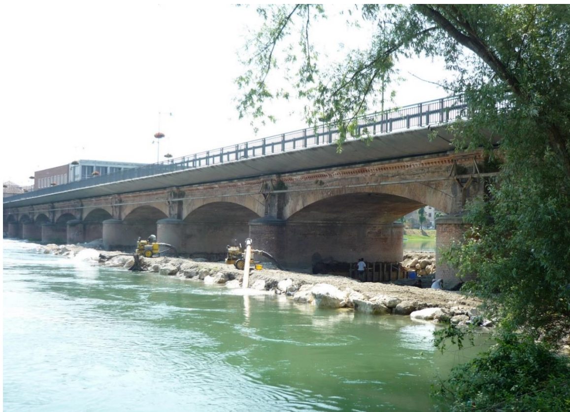
Fig.7 Intervento per l'aumento della capacità portante delle pile (2007) Fase di cantiere relativa agli interventi sulle pile verso la sponda sinistra
