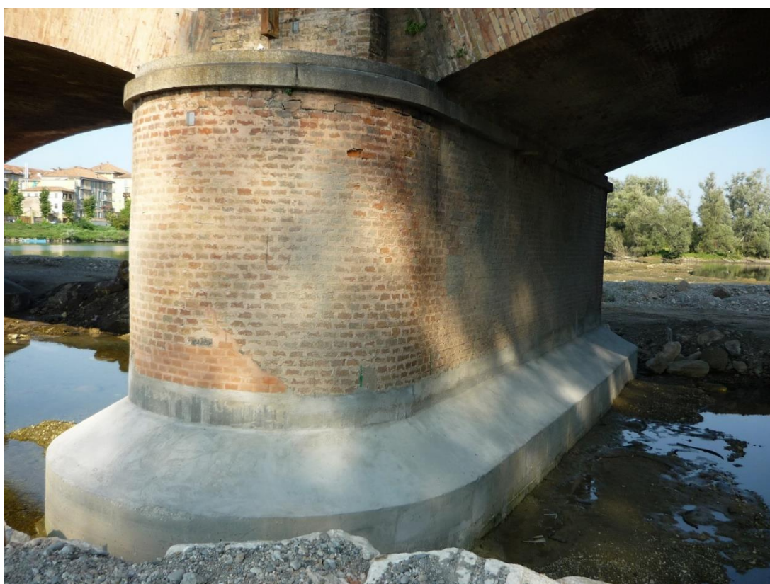
Fig. 10: Intervento per l'aumento della capacità portante delle pile (2007) – rifacimento colpetto Fase di cantiere relativa agli interventi sulle pile verso la sponda sinistra
