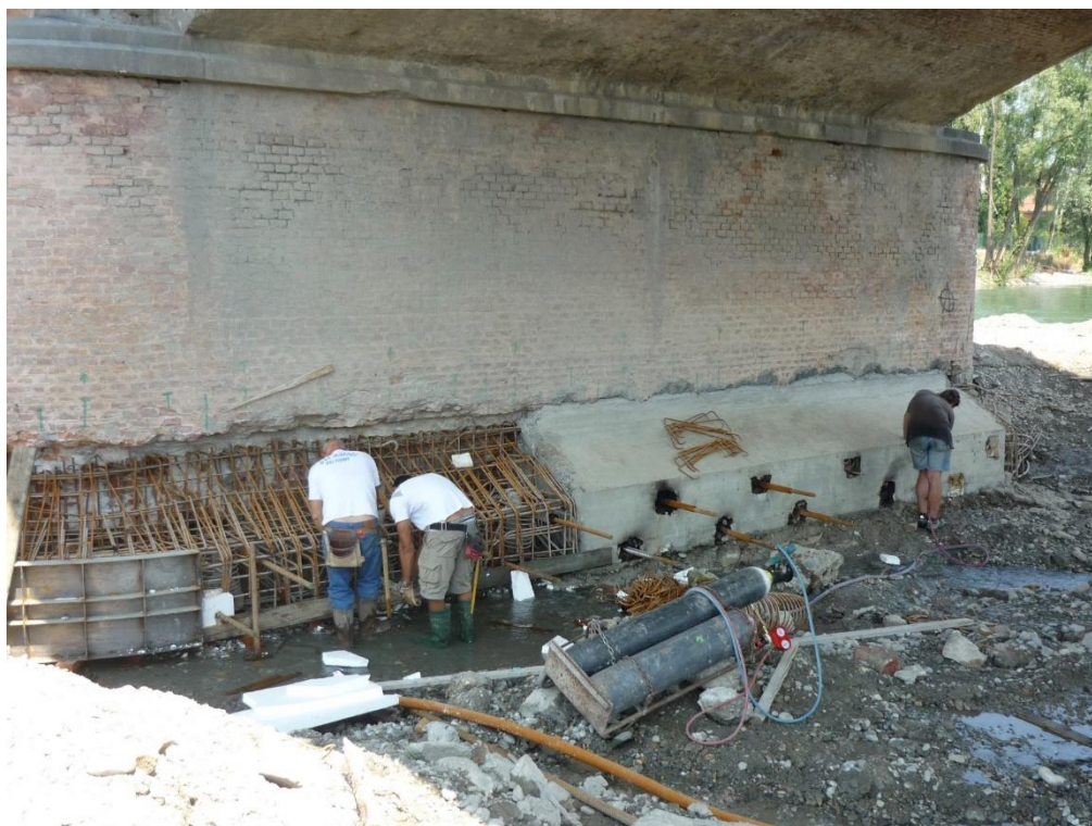
Fig.9 Intervento per l'aumento della capacità portante delle pile (2007) – rifacimento colpetto
